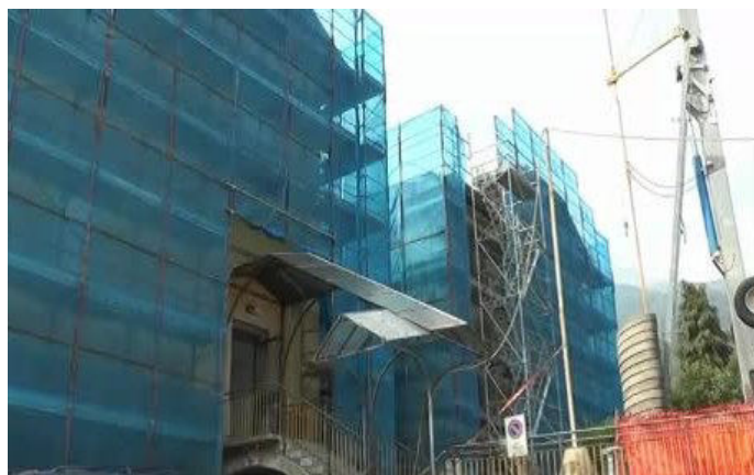
I lavori alla scuola elementare (da Teleboario.it)
